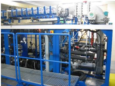
Wielofunkcyjny kanał obiegowy CTO-FC-CVH/12/8 - w trakcie prób odbiorowych
